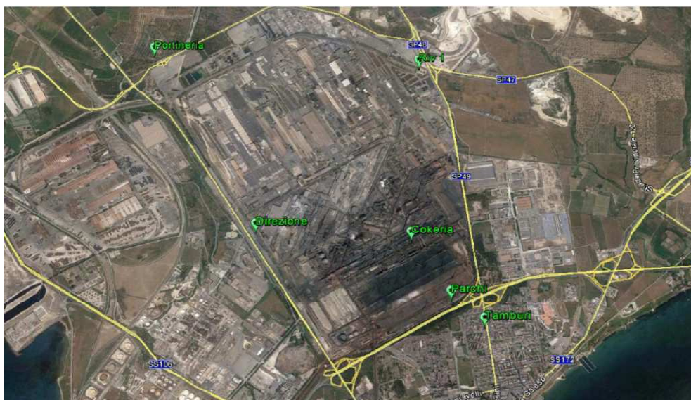
Fig.1 - Dislocazione delle centraline di monitoraggio
