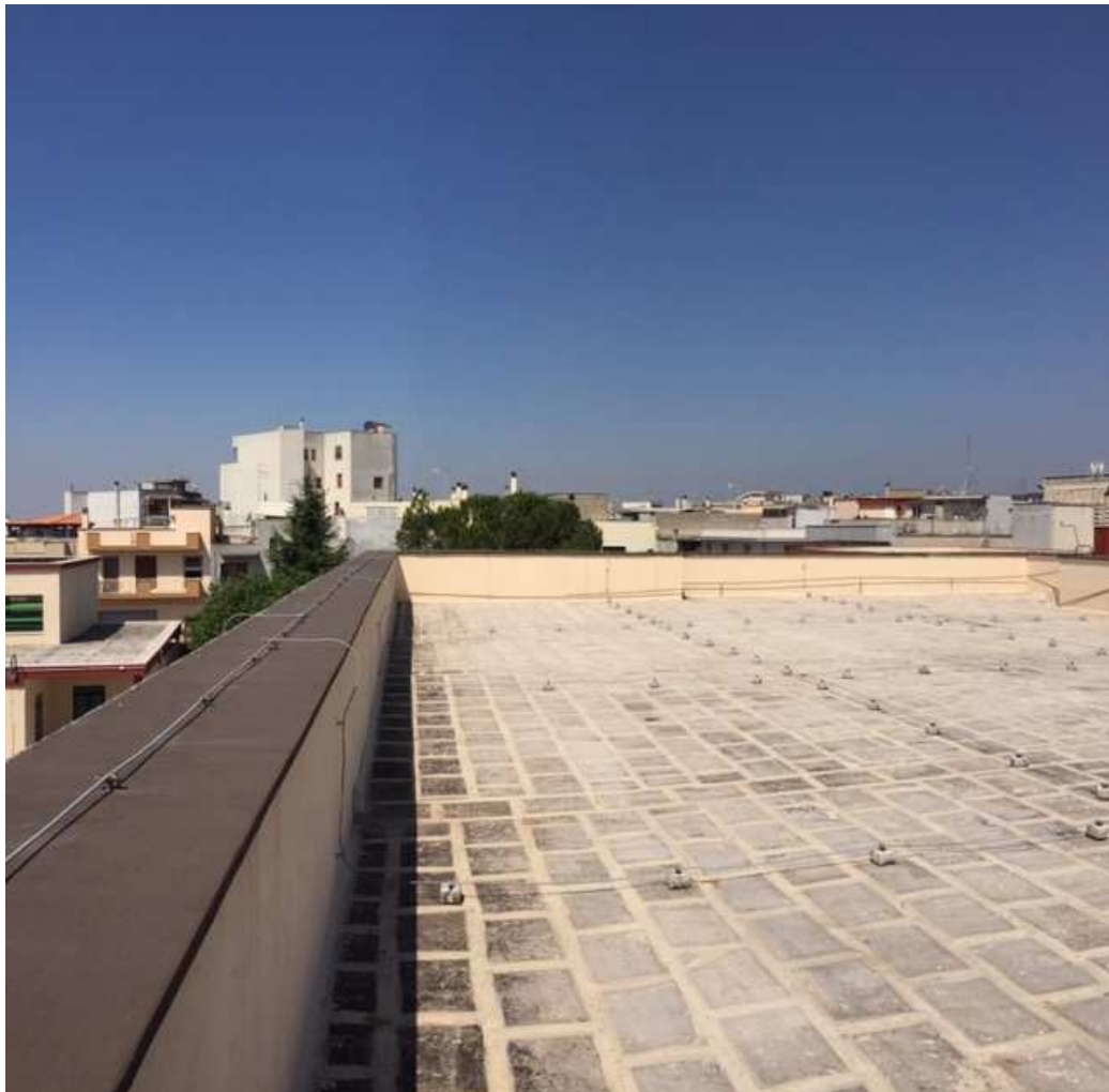
Figura 2 – Lastrico solare della scuola “Collodi” in Via Matteotti a Villa Castelli
